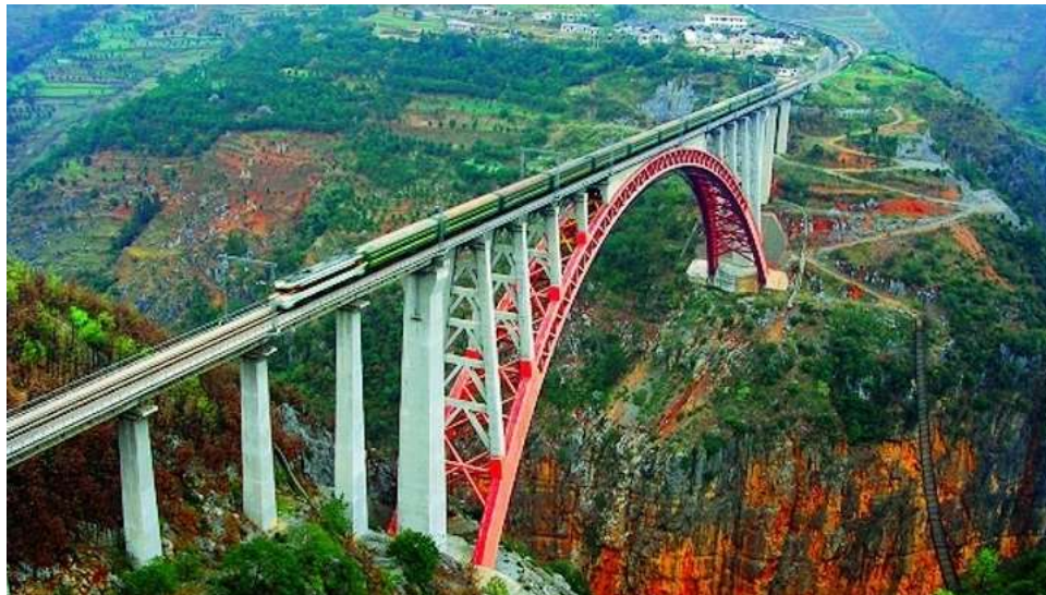
Figura 1. Ejemplo de puente ferroviario contemporáneo
