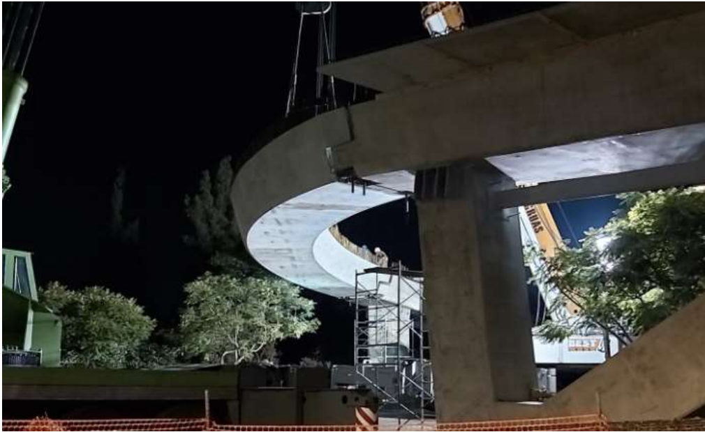
Figura 25. Montaje de trabe TCC.
