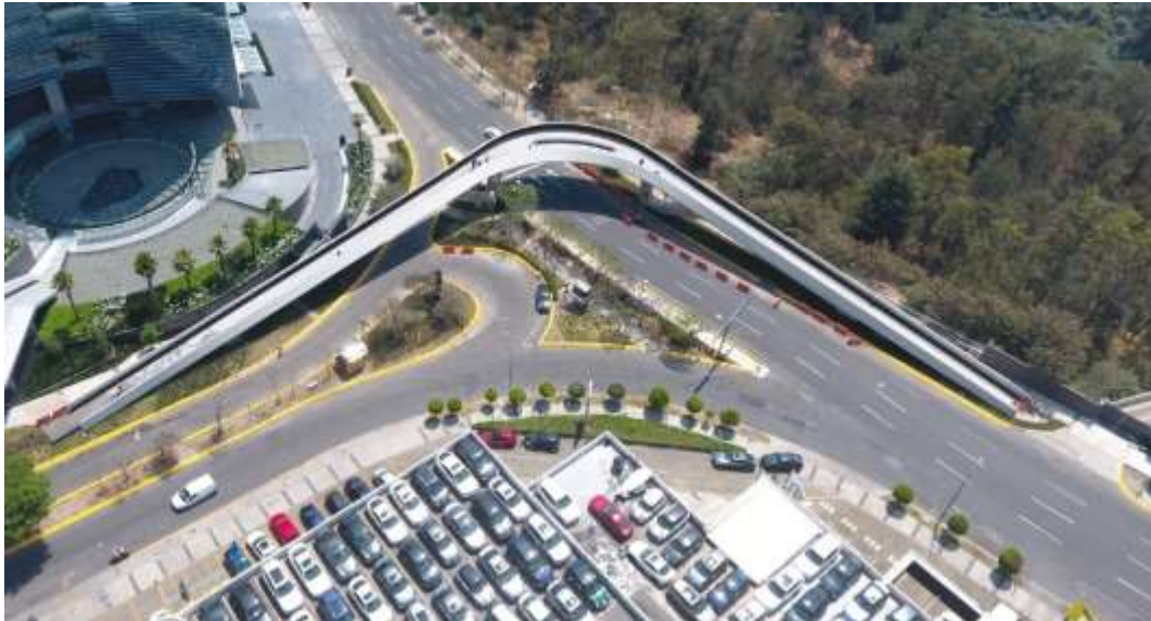
Figura 4. Puente peatonal motivo de estudio
